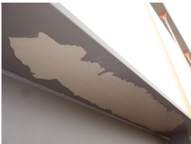
Foto č. 21 – K 04, odloupnutá PKO z podhledu horní pásnice levého hlavního nosníku v poli č. 13.
