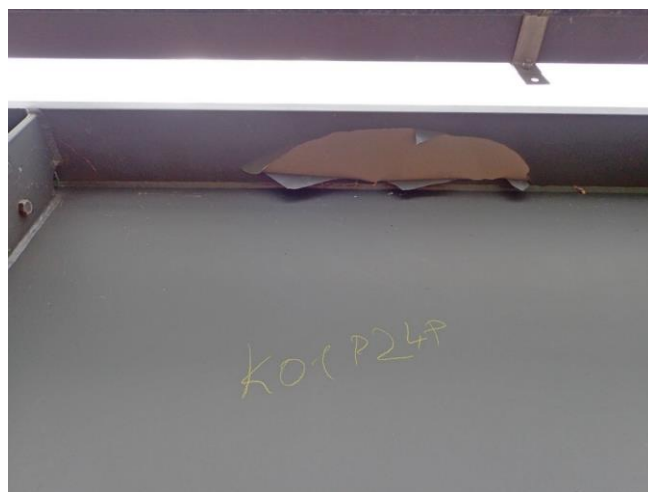
Foto č. 2 – K 01, poškozená PKO pravého hlavního nosníku v poli č. 24.
