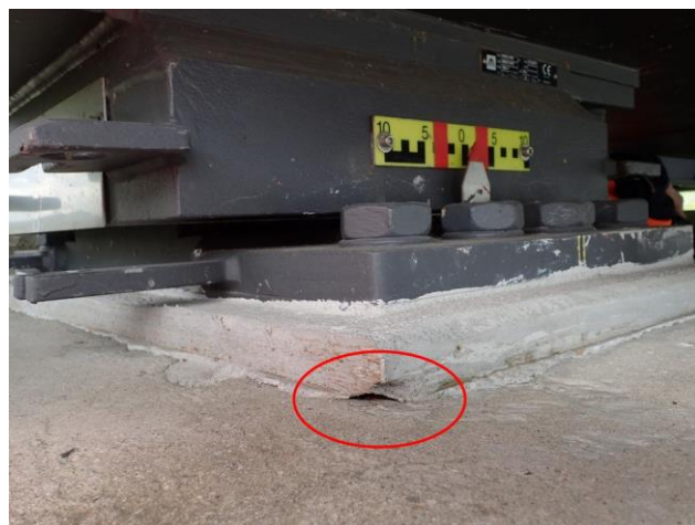
Foto č. 26 – K 04, dutina v podliti ložiska na P 05 vlevo.
