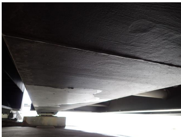
Foto č. 18 – K 03, odloupnutá povrchová úprava příčníku č. 1.
