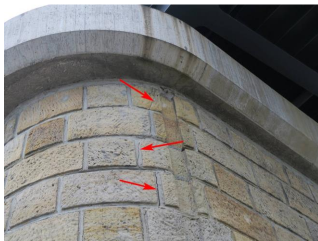
Foto č. 34 – P 03, svislá trhlina v horní, levé části pilíře směrem do otvoru 3.
