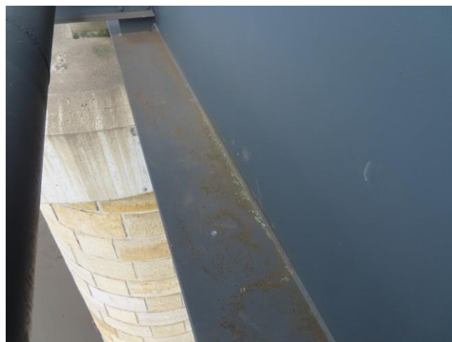
Foto č. 16 – K 03, prosvítající koroze dolní pásnice levého hlavního nosníku v poli č. 36.
