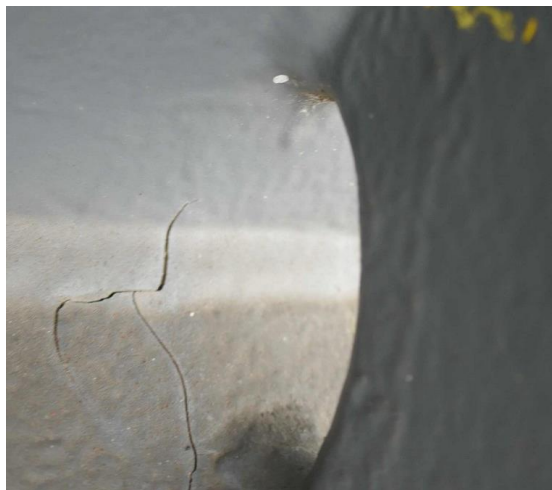
Foto č. 4 – K 01, poškozená PKO levého hlavního nosníku v poli č. 8.
