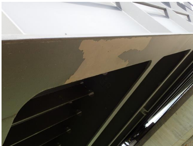
Foto č. 3 – K 01, poškozená PKO pravého hlavního nosníku v poli č. 23.
