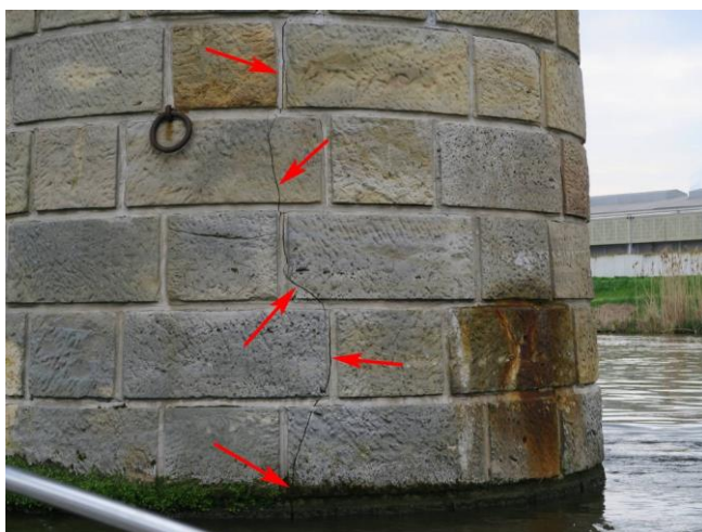
Foto č. 33 – P 03, svislá trhlina v levé části pilíře směrem do otvoru č. 4.
