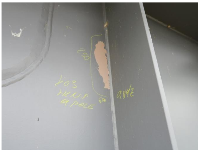
Foto č. 15 – K 03, poškozená PKO stojiny pravého hlavního nosníku v poli č. 9.
