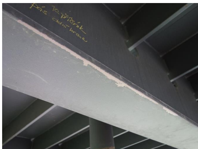
Foto č. 29 – K 05, odloupenutá PKO příčníku č. 10.
