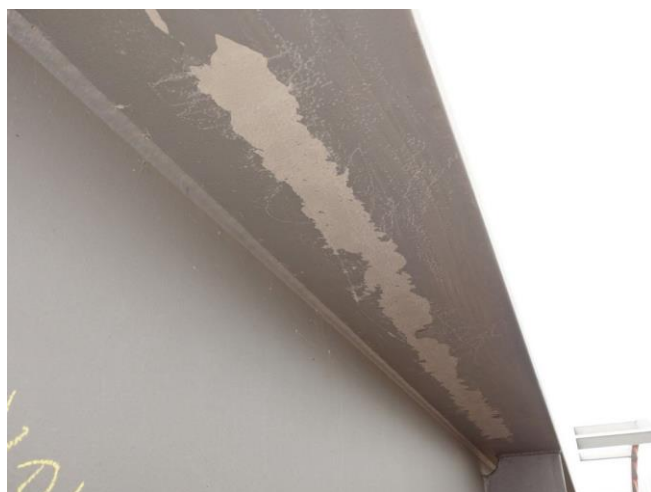
Foto č. 1 – K 01, poškozená PKO levého hlavního nosníku v poli č. 14.
