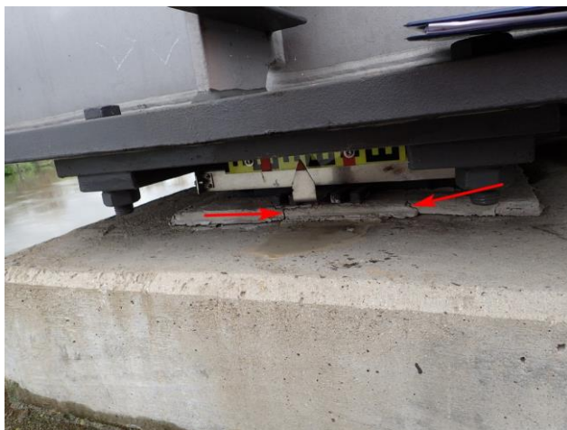
Foto č. 19 – K 03, rozpraskané podlití ložiska na P 03 vlevo.
