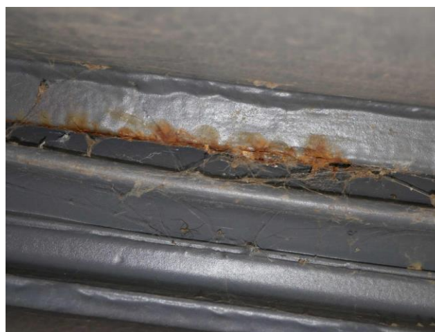
Foto č. 30 – K 05, protékající koroze závěru mezi K 05 a O 02.
