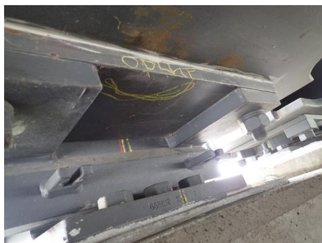
Foto č. 12 – K 02, prorážející koroze u příčníku č. 1, u ložiska na P 02 vpravo.
