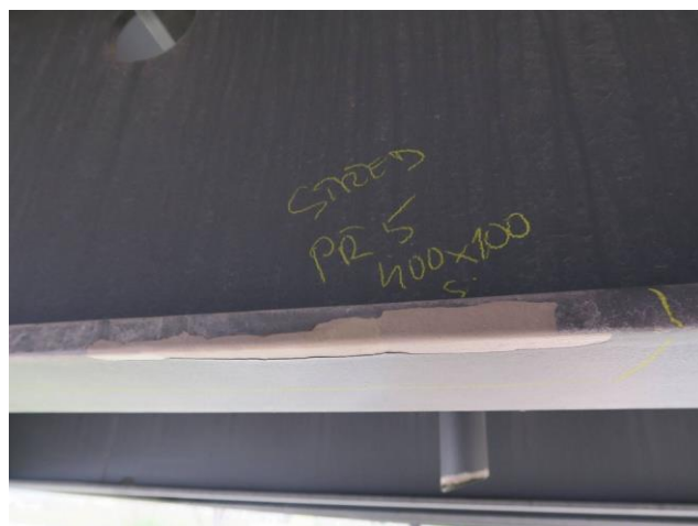
Foto č. 8 – K 01, odloupená PKO dolní pásnice příčnicku č. 5.
