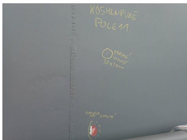
Foto č. 28 – K 05, odloupenutá PKO stojiny pravého nosníku v poli č. 11 z vnější strany.
