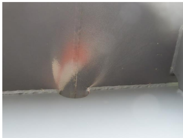
Foto č. 10 – K 02, přestříkaná PKO levého hlavního nosníku barvou táhla v poli č. 20.
