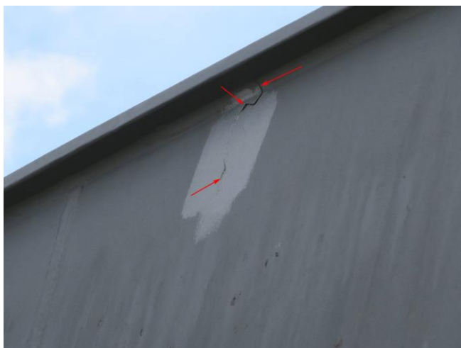
Foto č. 17 – K 03, horní příčné ztužení č. 1 popraskaný a vzdutý nátěr po opravě.
