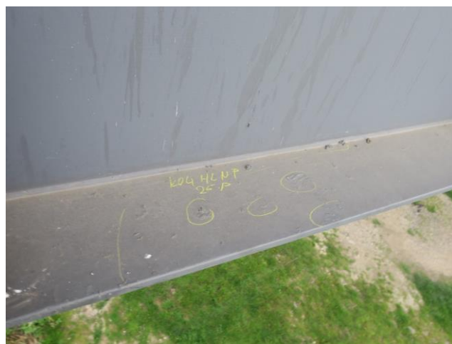
Foto č. 22 – K 04, zatřené nečistoty na dolní pásnici a znečištěná PKO stojiny barvou v poli č. 25 pravého hlavního nosníku.
