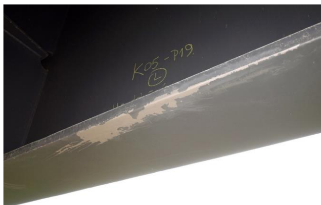
Foto č. 27 – K 05, odloupenutá PKO z pohledu dolní pásnice levého hlavního nosníku v poli č. 19.
