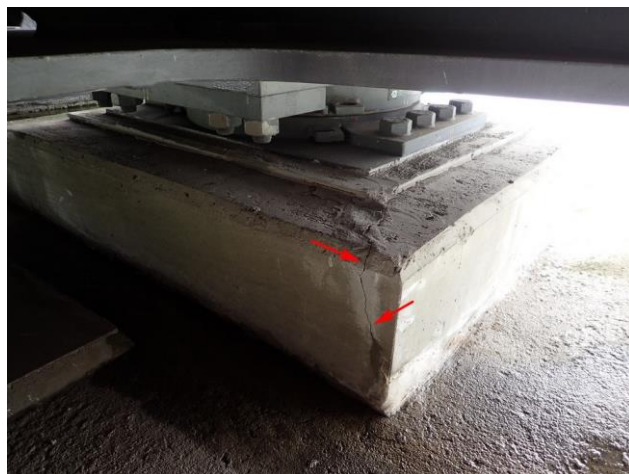
Foto č. 13 – K 02, trhlina v úložném bloku pod ložiskem K 02 na P 03 vpravo.
