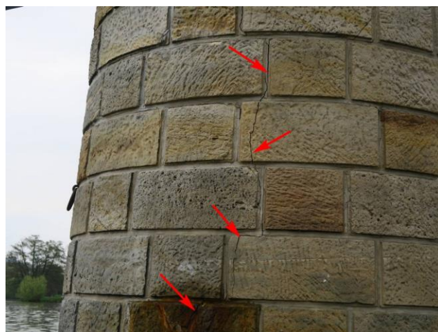
Foto č. 32 – P 03, svislá trhlina v levé části pilíře směrem do otvoru č. 3.
