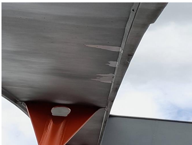
Foto č. 23 – K 04, odloupená PKO z podhledu levého oblouku mezi táhly č. 3 – 4.
