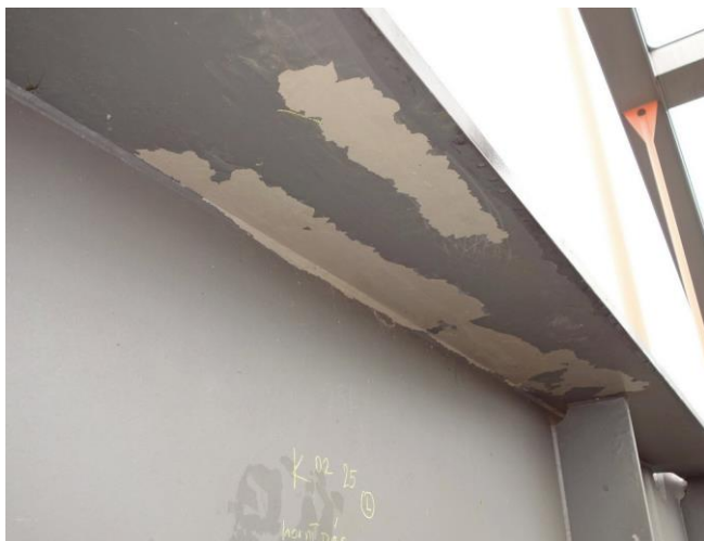
Foto č. 9 – K 02, poškozená PKO levého hlavního nosníku v poli č. 25.
