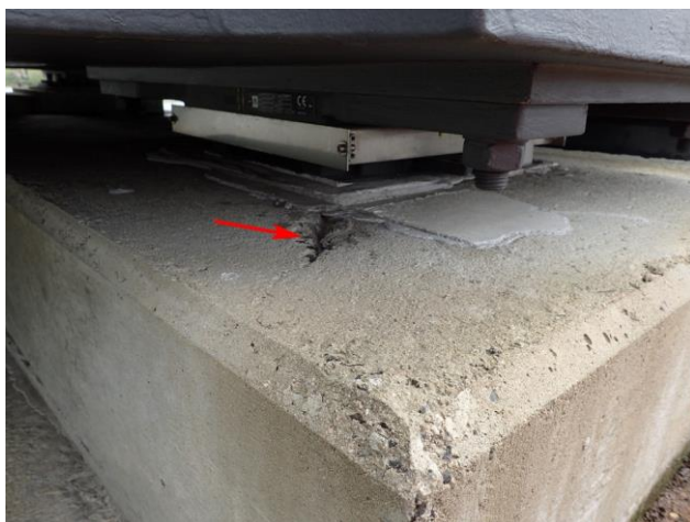
Foto č. 25 – K 04, kaverna v betonu úložného bloku na P 04 vlevo.
