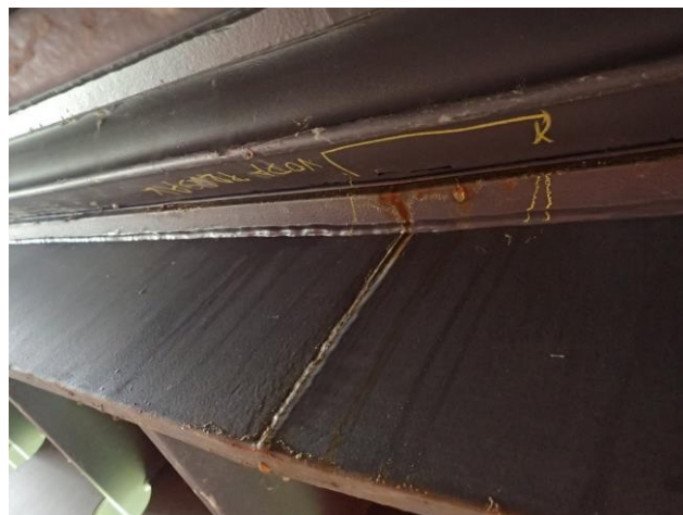
Foto č. 14 – průsak v závěru mezi K 01 a K 02 na P 03.
