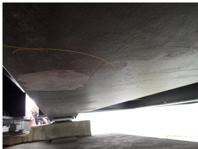
Foto č. 24 – K 04, odloupená PKO z podhledu příčniců č. 1.
